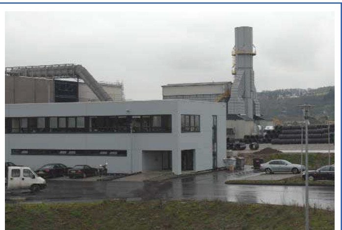
TSW-Verwaltungsgebäude mit der neuen Entstaubungsanlage im Hintergrund
