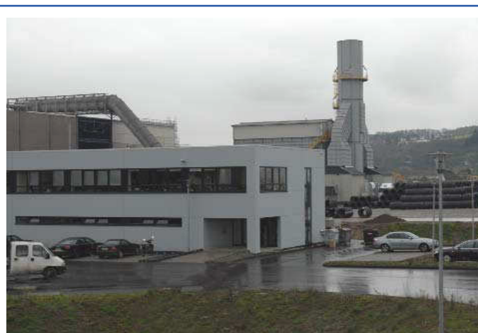
TSW-Verwaltungsgebäude mit der neuen Entstaubungsanlage im Hintergrund
